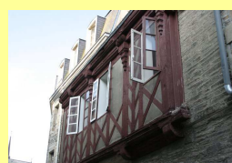
Maison à pans de bois
